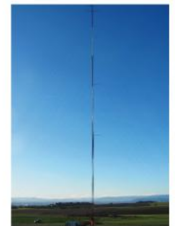
Mât de mesure de vent
